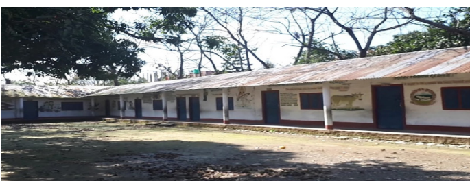
Oud gebouw te verbouwen naar nieuw kinderhuis
